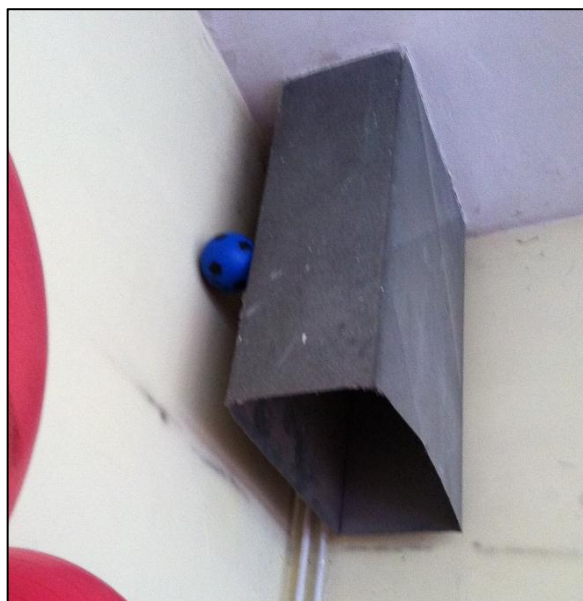
Slika 9: Opuščeni kanalski razvodi v telovadnicah
