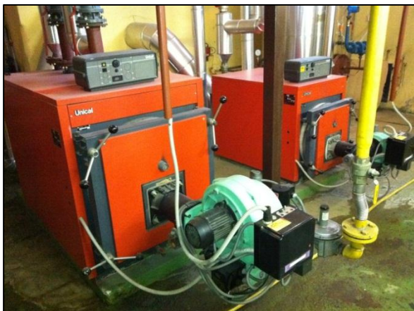
Slika 3: Plinski kotli in črpalke za posamezne ogrevalne kroge
