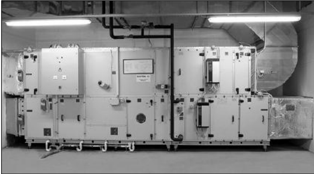
Slika 16: Modularna klimatska naprava za izkoriščanje odpadne toplote
