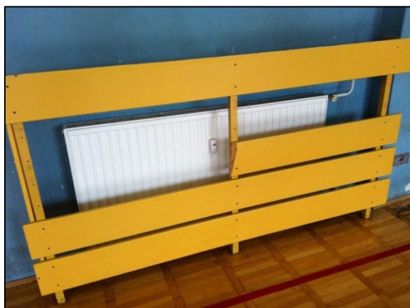
Slika 6: Radiatorji v dvoranah in garderobah brez termostatskih ventilov (Staničeva)
