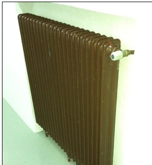
Slika 4: Radiatorji s termostatskimi ventili in brez njih
