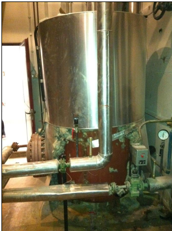
Slika 10: Poškodovana toplotna izolacija boilerja za pripravo STV
