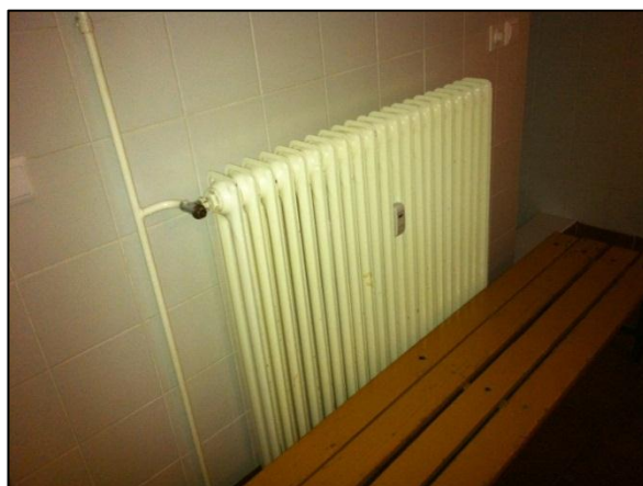
Slika 6: Radiatorji v dvoranah in garderobah brez termostatskih ventilov (Staničeva)
